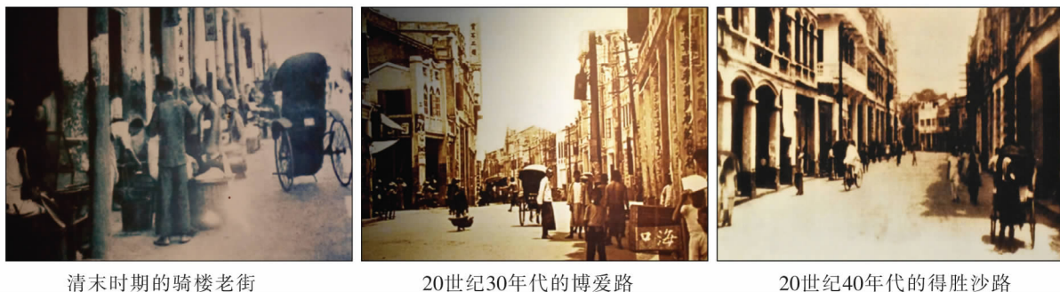
图1 历史上的海口骑楼老街(来源:海口骑楼与侨文化展览馆)
